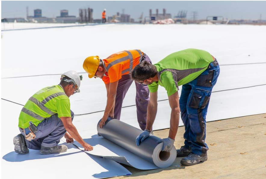
Foto 2.2 (Verlegung) EverGuard TPO/FPO - Montage.
